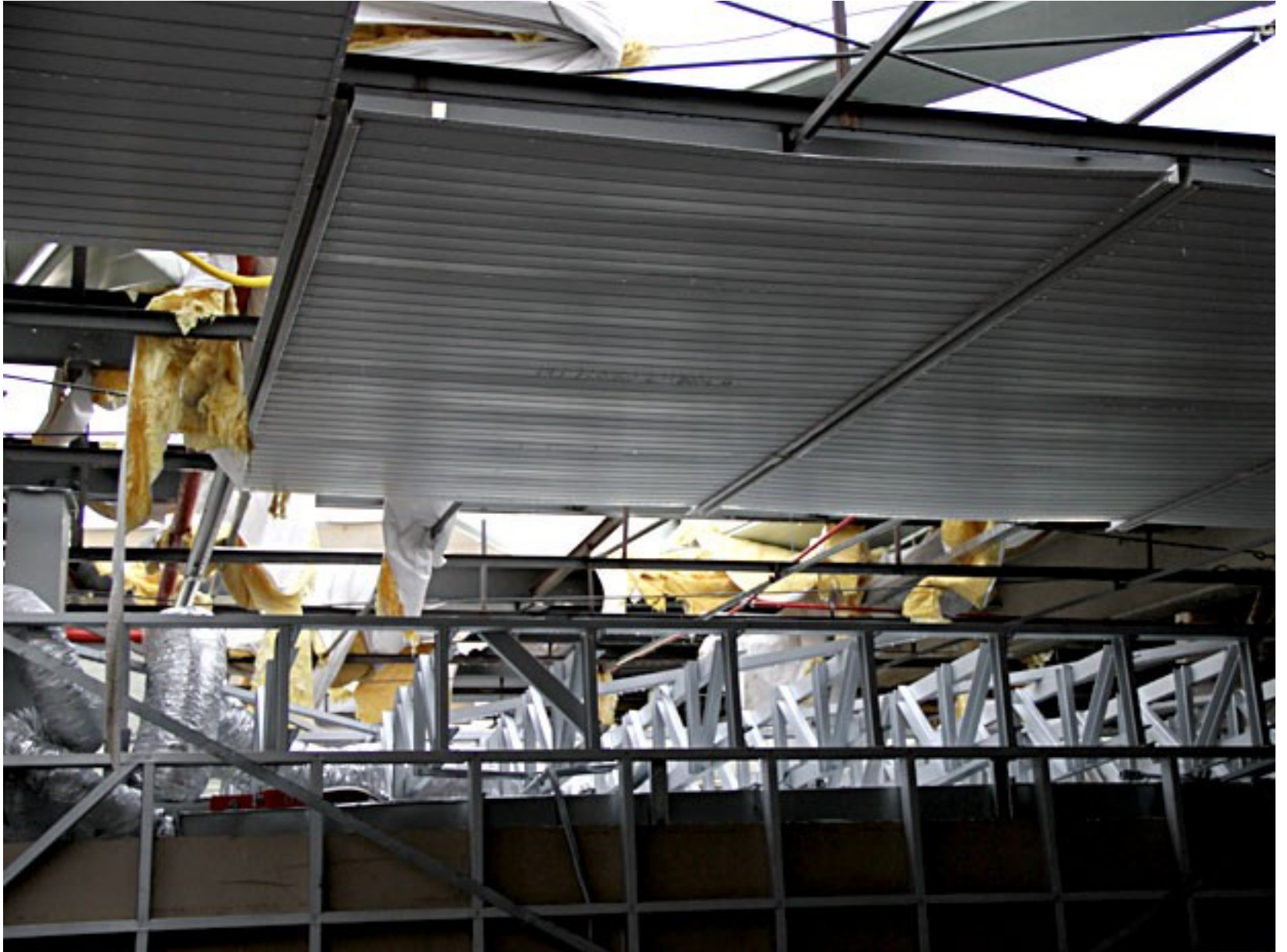
Teto destelhado em área do Aeroporto JK, em Brasília (Foto: Vianey Bentes/TV Globo)
